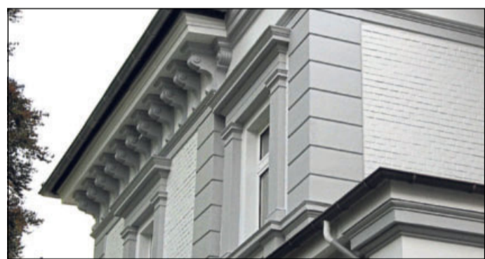
Viele Zierelemente sind an der Villa Becker noch erhalten: Bei der Sanierung wurden sie alle farblich neu gefasst.
