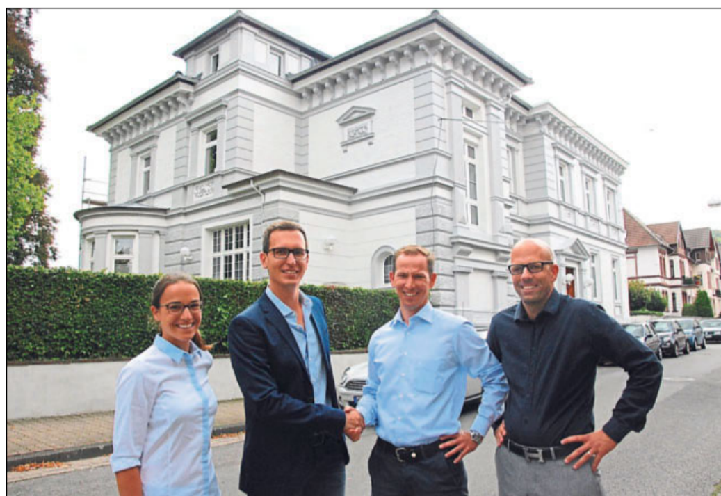
Die Sanierung ist abgeschlossen. Dr. Sarah Heretsch (links im Bild) mit Mark Becker und Nils Becker (rechts) vor der Villa. Fotos: Michael Robrecht
