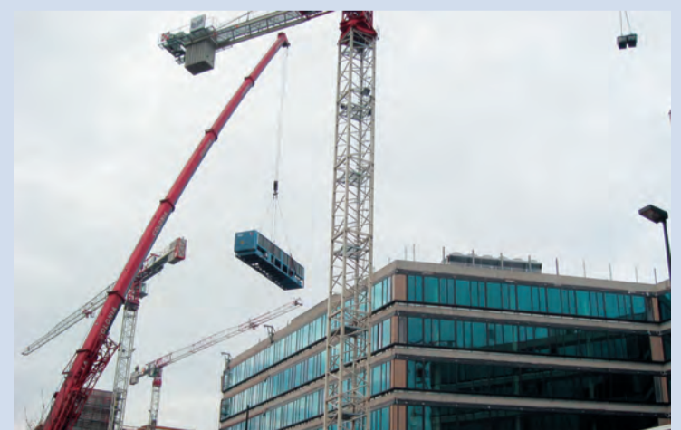
Herausfordernder Kraneinsatz zum Transport der Kältemaschine in luftiger Höhe.
