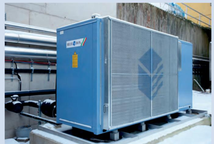
Kompaktkältemaschine mit Freikühlfunktion
