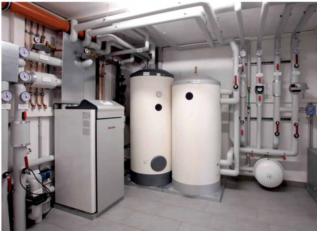
Energiesparende Brunnenwasser-Wärmepumpenanlage zur Beheizung eines Einfamilienwohnhauses samt Warmwasserbereitung.
