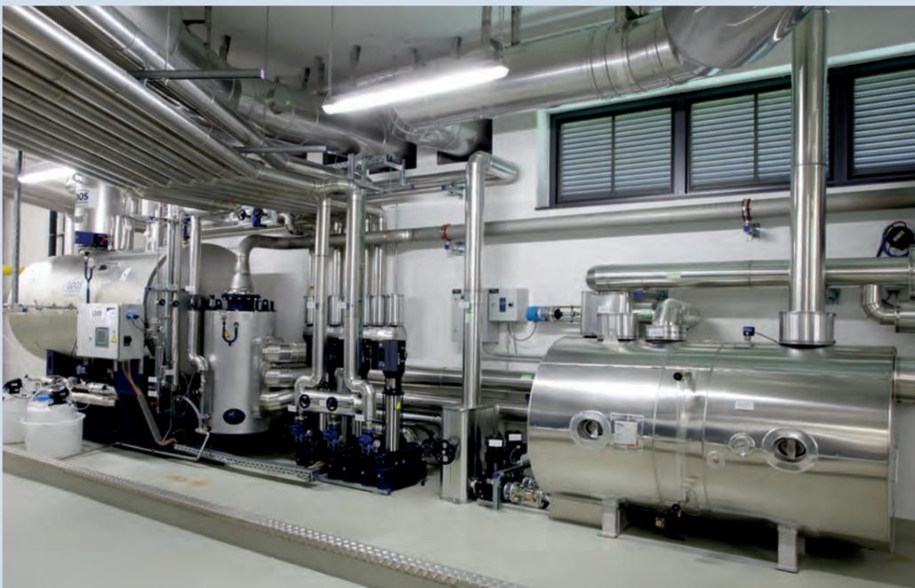
Zentrale Speisewasseraufbereitungsanlage zur Versorgung der beiden Dampfkessel
