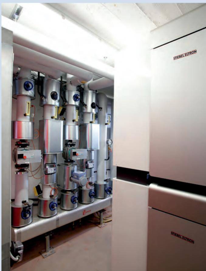
Wärmepumpen-Kaskade versorgt die Fußboden- und Luftheizung
