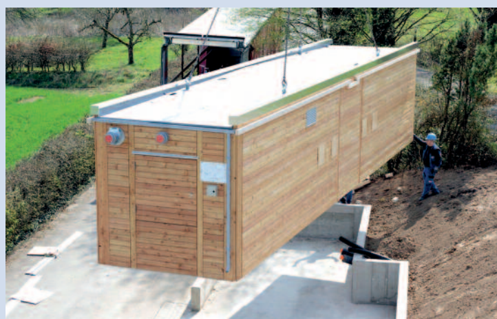
Anlieferung und Aufstellung der Heizungsanlage
