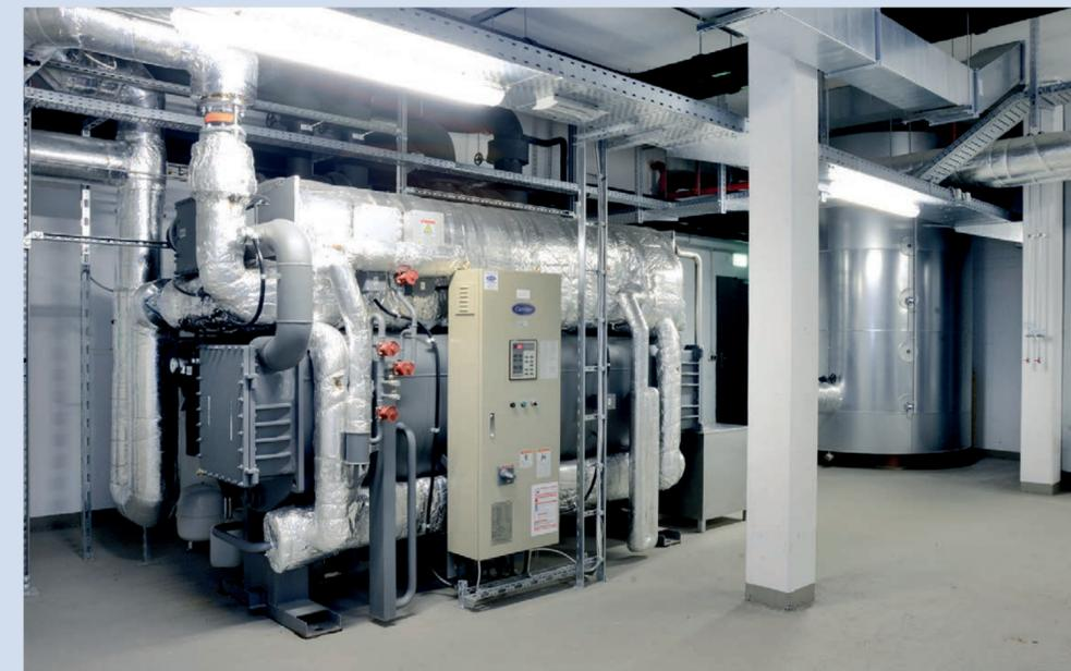
Absorberkältemaschine mit Pufferspeicher
