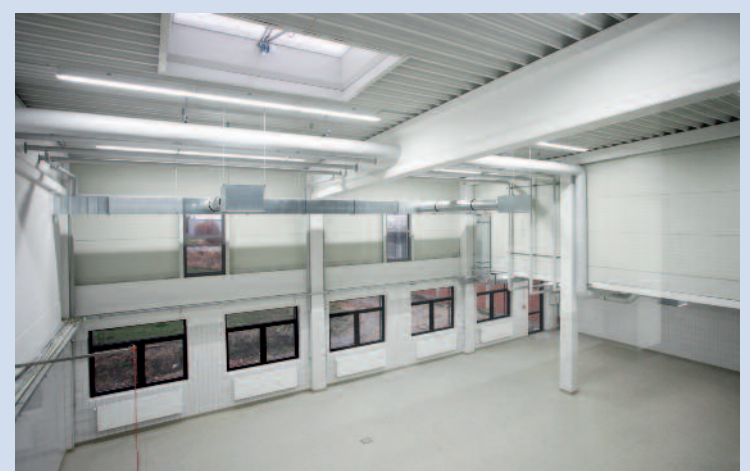
Blick in die neue Produktionshalle
