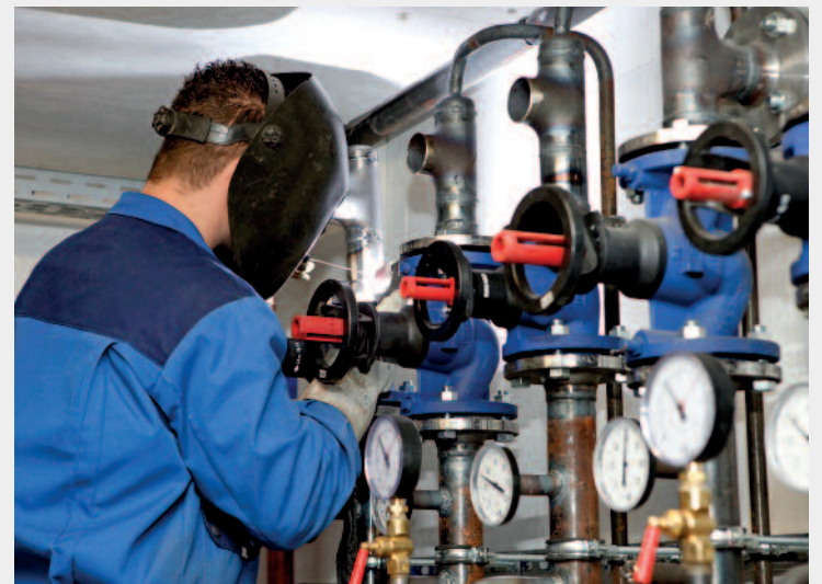
Monteur Mark Drenkelfuß beim Verteileraufbau
