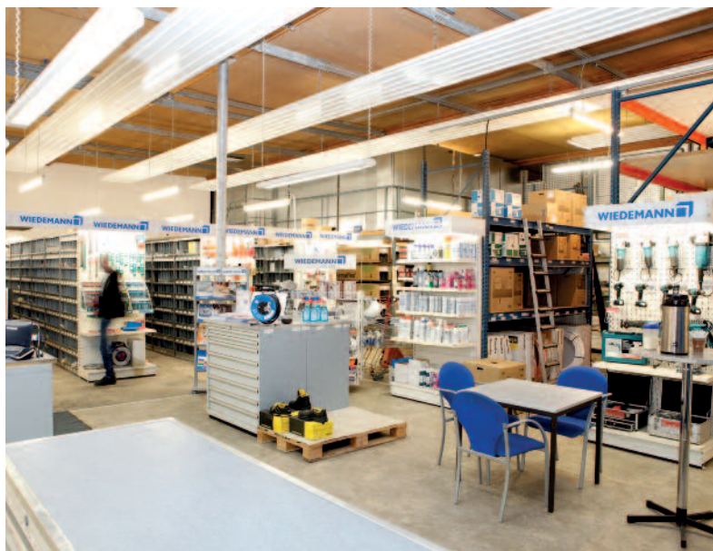
Neues Abhollager mit Deckenstrahlheizung
